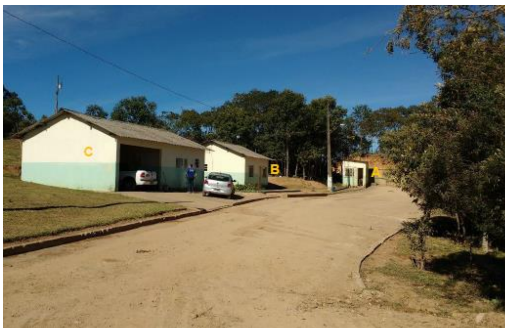
Figura 14: Guarita (A), Apoio administrativo (B) e Apoio operacional (C).
