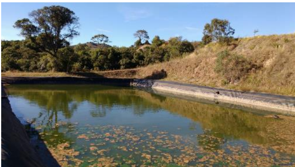
Figura 12: Lagoa facultativa do Aterro Sanitário de Andradás. Data: Jun/2016.
