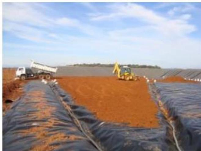
Figura – Camada de proteção da manta PEAD.
