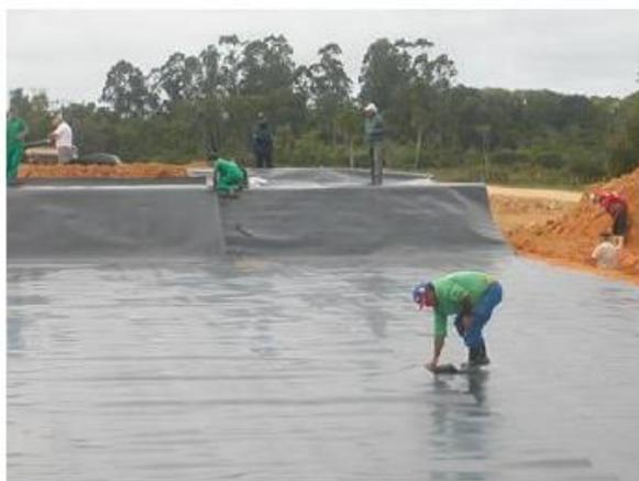
Figura – Instalação da manta.
