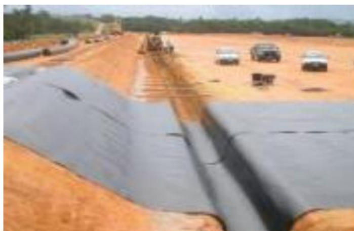
Figura – Vala para execução da drenagem de líquidos.
