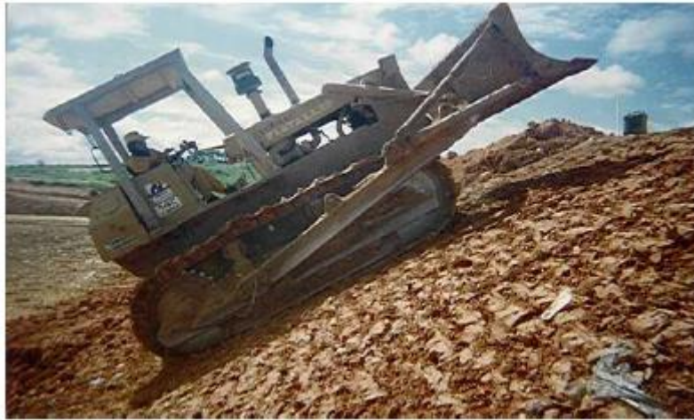
Figura – compactação dos resíduos.
