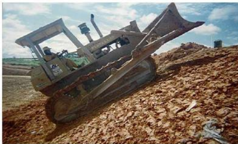
Figura 14 – exemplo de compactação dos resíduos.
