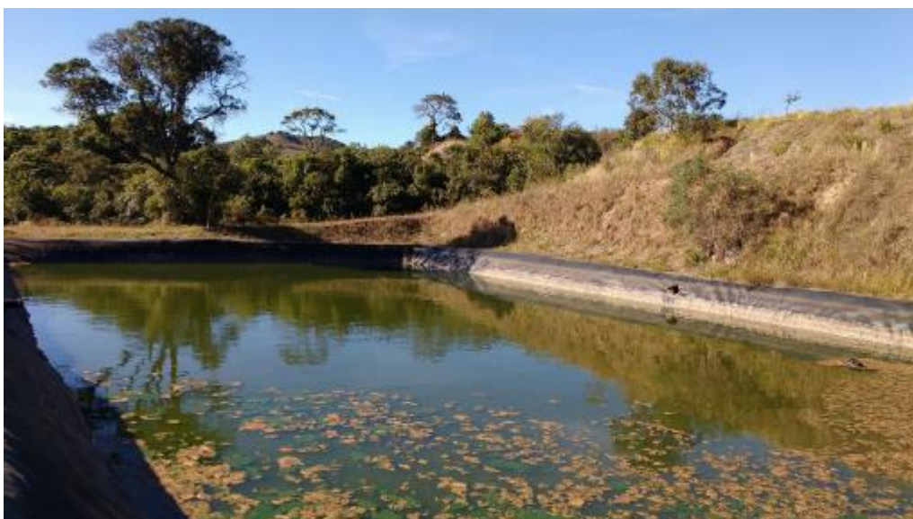
Figura 10: Lagoa facultativa do Aterro Sanitário de Andradas. Data: Jun/2016.
