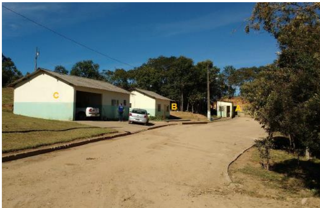
Figura 13: Guarita (A), Apoio administrativo (B) e Apoio operacional (C).
